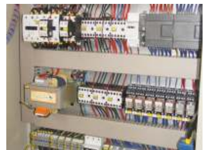
Schaltschrank / SPS-Steuerung
